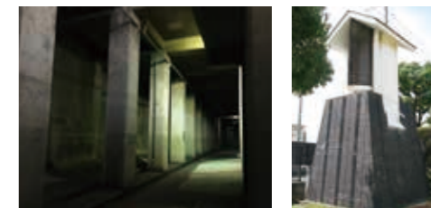
10 南向陽調整池
